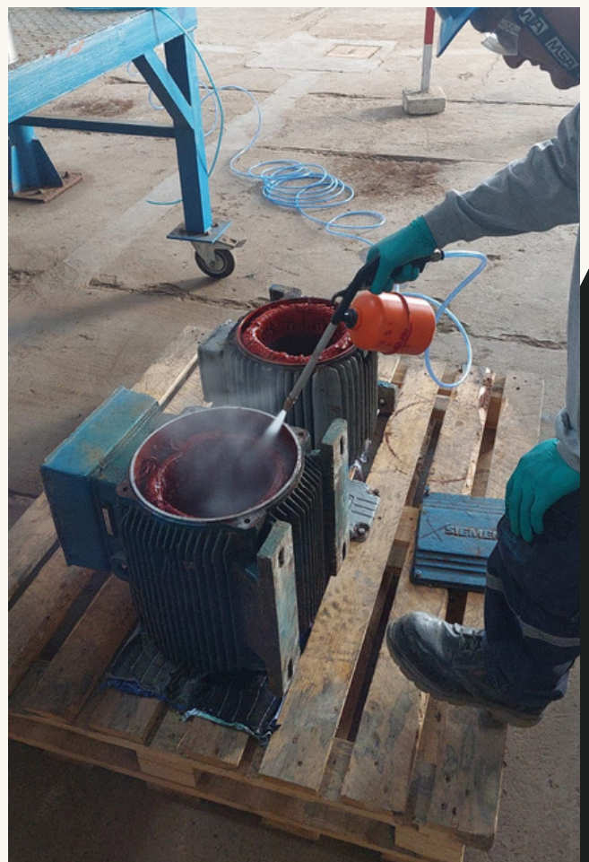
Mantenimiento e instalación de motores.
