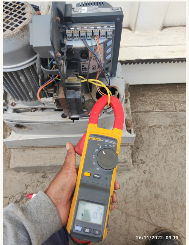
Mantenimiento y reparación de portón industrial corredizo.
