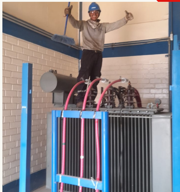
Mantenimiento de transformadores.
