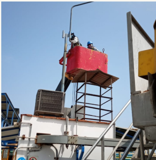
Mantenimiento e instalación de luminarias.
