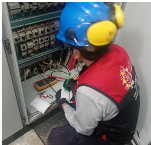
Diagnóstico de tableros eléctricos fuerza y control.
