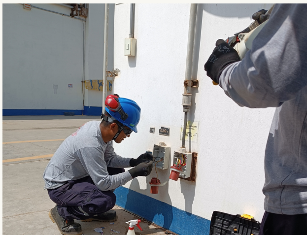
Mantenimiento e instalación de tomas industriales.
