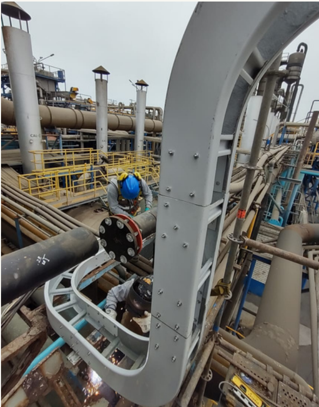
Cableado estructurado con bandejas portacables.
