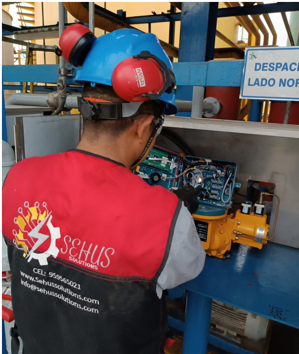
Instalación y puesta en marcha de contometro.
